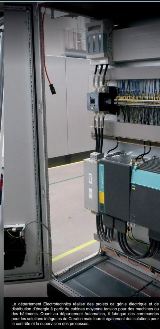
Le département Electrotechnics réalise des projets de génie électrique et de distribution d'énergie à partir de cabines moyenne tension pour des machines ou des bâtiments. Quant au département Automation, il fabrique des commandes pour les solutions intégrales de Ceratec mais fournit également des solutions pour le contrôle et la supervision des processus.
